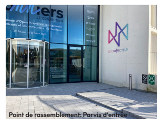
Point de rassemblement : Parvis d'entrée
